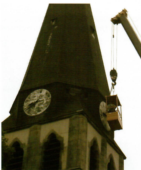
Die angegriffenen Zifferblätter wurden abgenommen, mit Hilfe einer an einem Hubwagen befestigten Gondel
