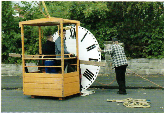
Ein neues Zifferblatt wird gleich nach oben gezogen
