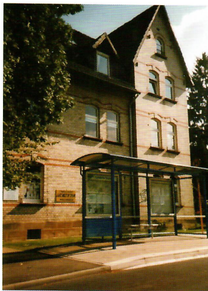
Das Jugendzentrum in der Helmarshäuser Straße
